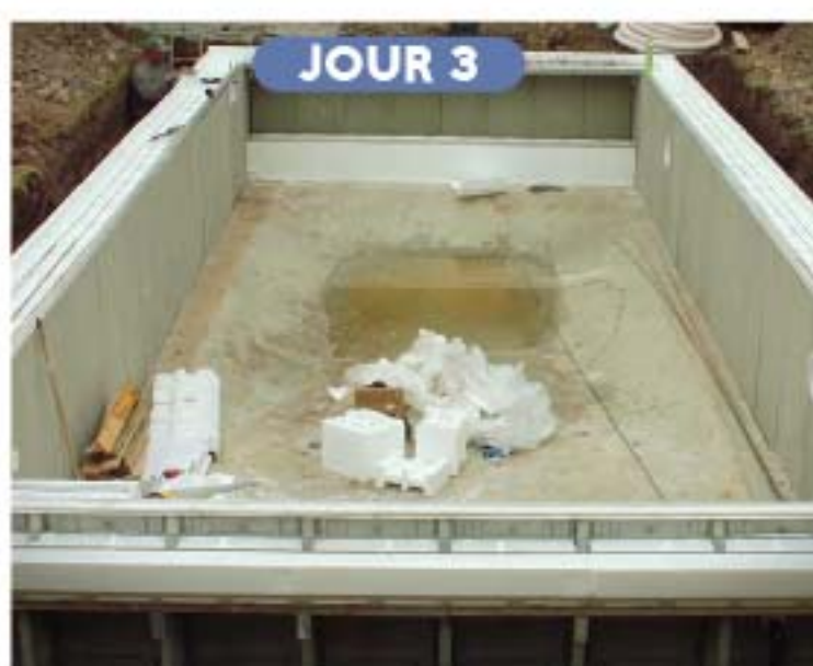
Pose et réglage de la structure puis mise en place des pièces à sceller.
