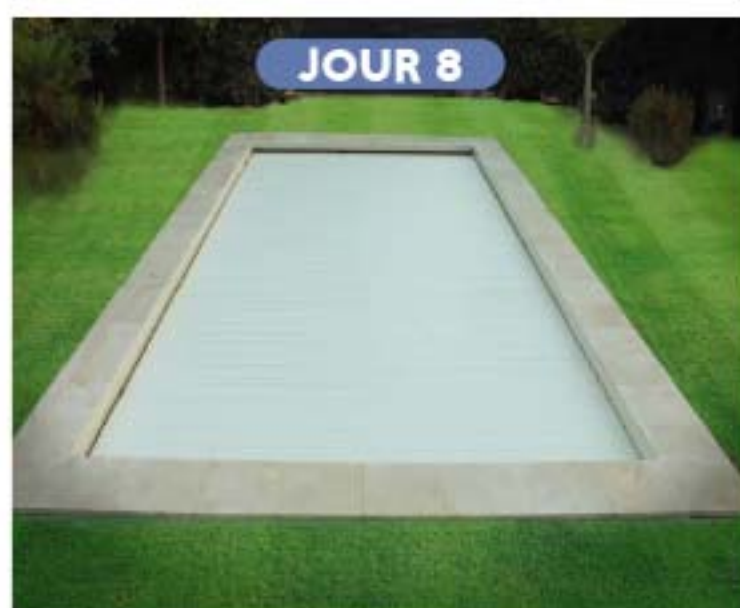
Réception de la piscine terminée.
