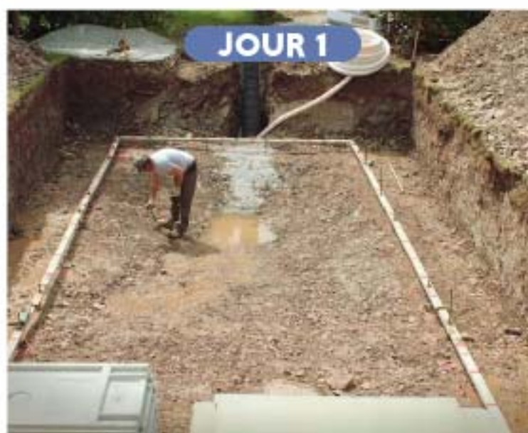
Terrassement et marquage de la future forme de fond.
