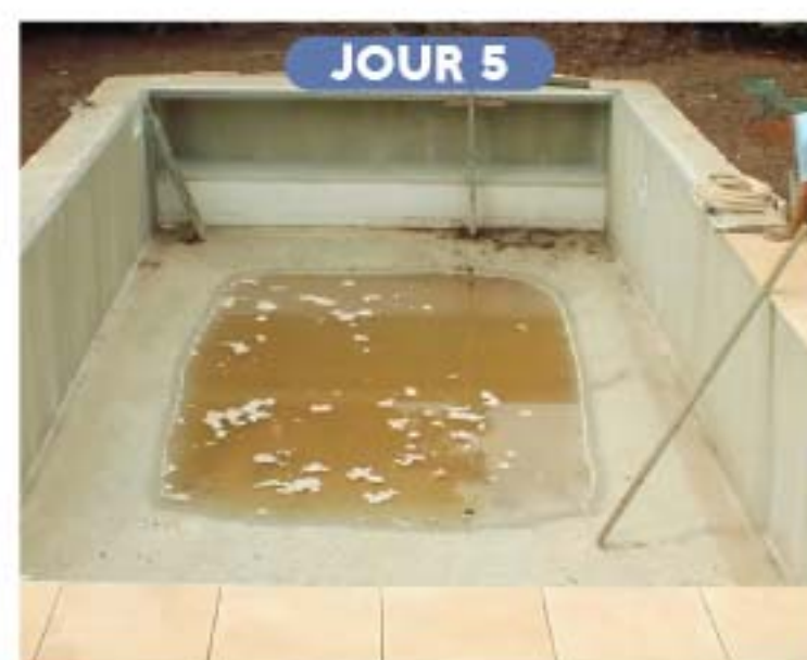
Passage des canalisations et drains. Remblaiement et pose des dalles. Mise en place d'un poolterre.
