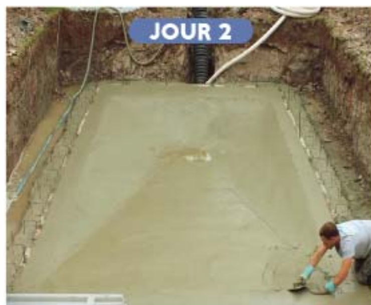
Coulage du béton pour le radier de fond.
