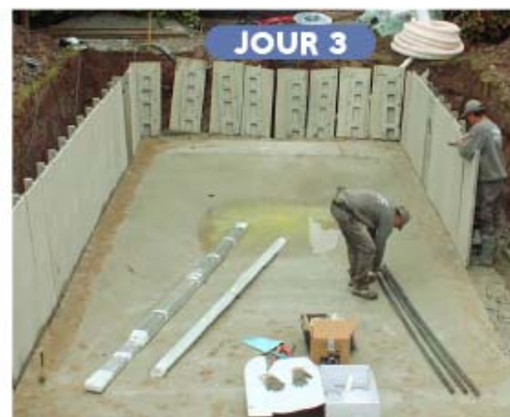
Disposition des panneaux de la structure.
