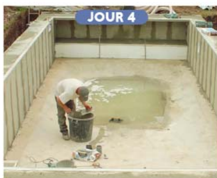
Coulage du béton pour les chaînages haut et bas.
