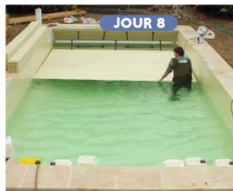
Mise en eau et installation du volet. Raccordement de la filtration et mise en place des brides.
