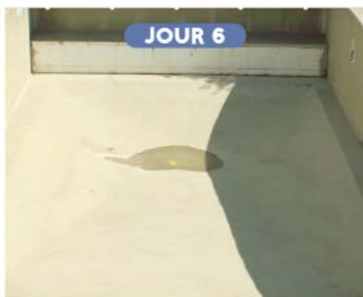
Préparation du bassin. Nettoyage et finitions.
