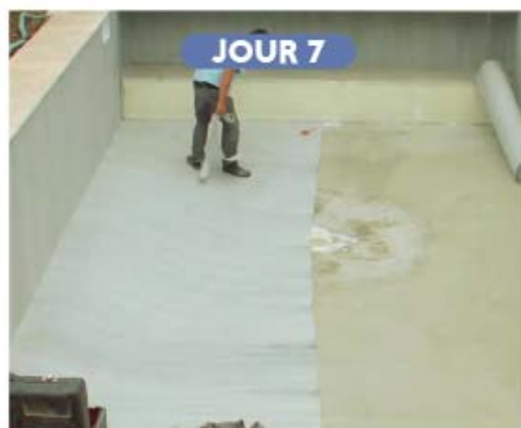
Pose du revêtement d'étanchéité.
